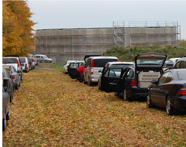
Ein Blick auf die Großbaustelle
